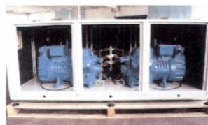
Unità di compressione da 2x35 hp Frascold
